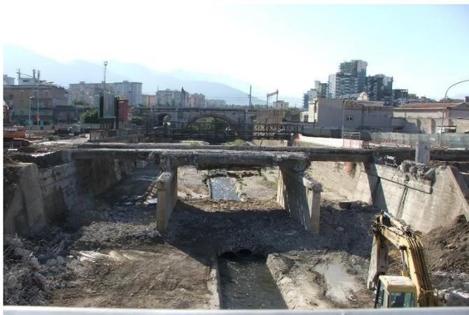
**Ponte a 6 corsie –extradossato-senza pile in alveo (a spinta annullata) schiena d'asino per garantire la massima sezione di effluo per eventuale piena con ritorno a 50 anni**
